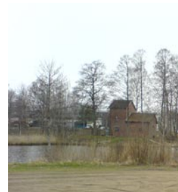
Den gamla transfor-matorstationen vid strandkanten.
