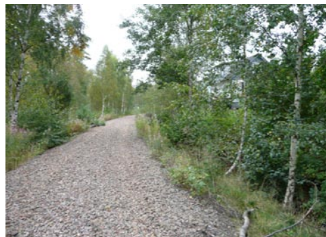
Den gamla banvallen längs med bäcken mot Fedingesjön på vilken gång- och cykelstråket föreslås fortsätta norrut. Brännarebäcken skymtar till höger om banvallen.
