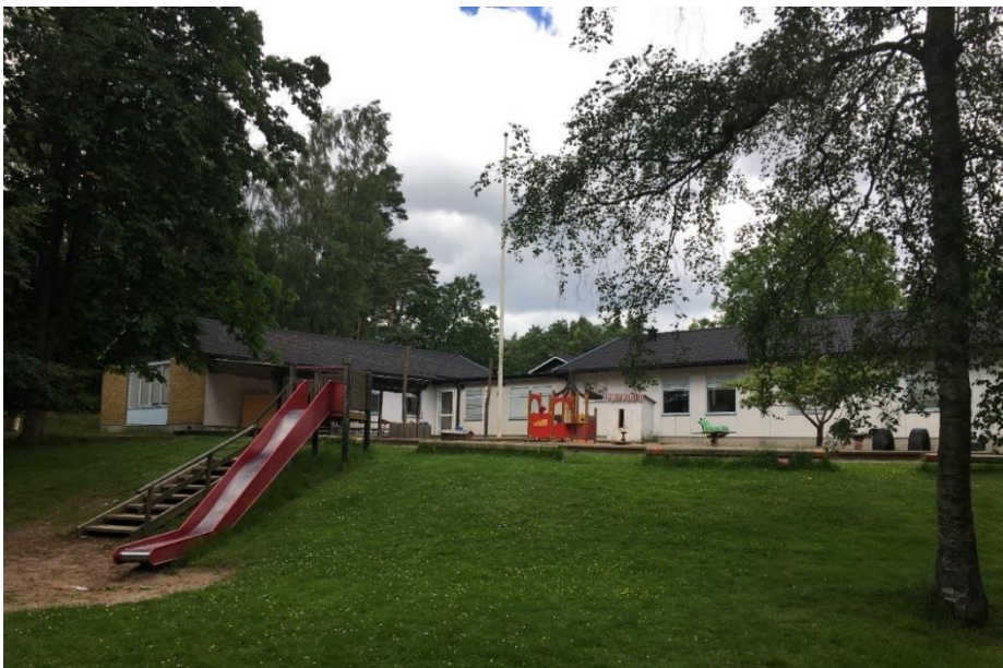
Bild: Befintlig förskola som kommer att rivas.
