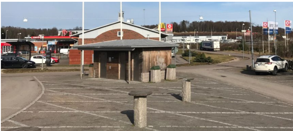
Vy mot norr och servicebyggnaden i vid rastplatsens infart. Till vänster om byggnaden ligger infarten till rastplatsen och till höger finns utfarten.
