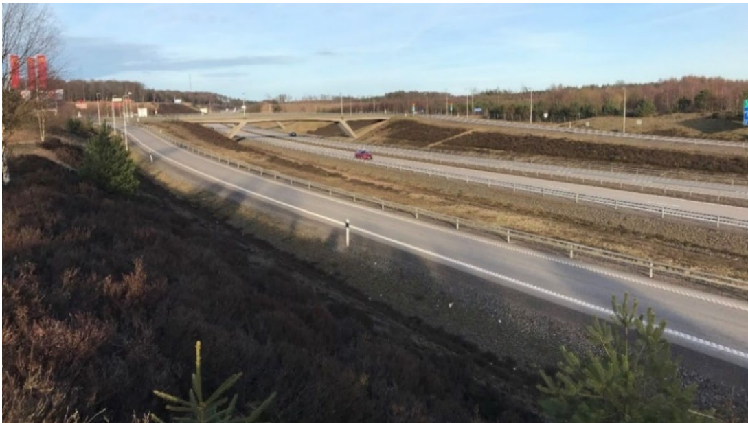
Befintlig vall och dike för påfartsrampen till väg E4 intill den södra delen av planområdet.
