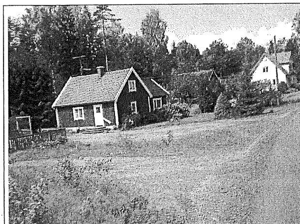
Bilden visar fastigheterna Fagerhult 1:173 och 1:128 väster om Bjärabyggevägen. Bjärabyggevägen övergår här till enbart gång- och cykelväg med anslutning till den nya industrigatan (Snapphaneallén).
