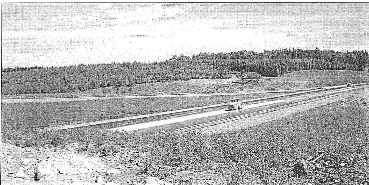
Bilden visar bl.a. nivåskillnaden mellan Väg E 4 och avfartsrampen samt planområdets norra del. I bildens centrala del syns den färdigställda vändplatsen som avslutar den tidigare markvägen.
